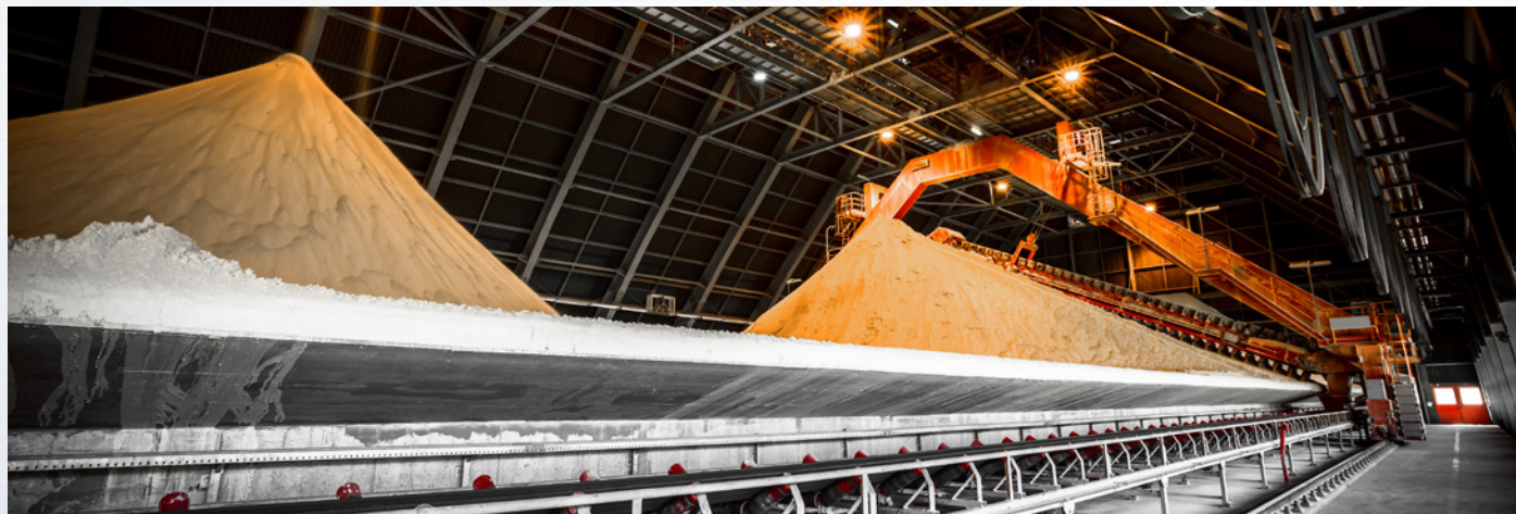
Figura 1-13. Transportador raspador reclamando yeso en un almacén
